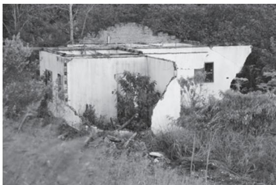
Casa entregue pelo plano de mitigação já destruída pela erosão do solo: foram construídas nas margens de barrancos e em terreno instável
