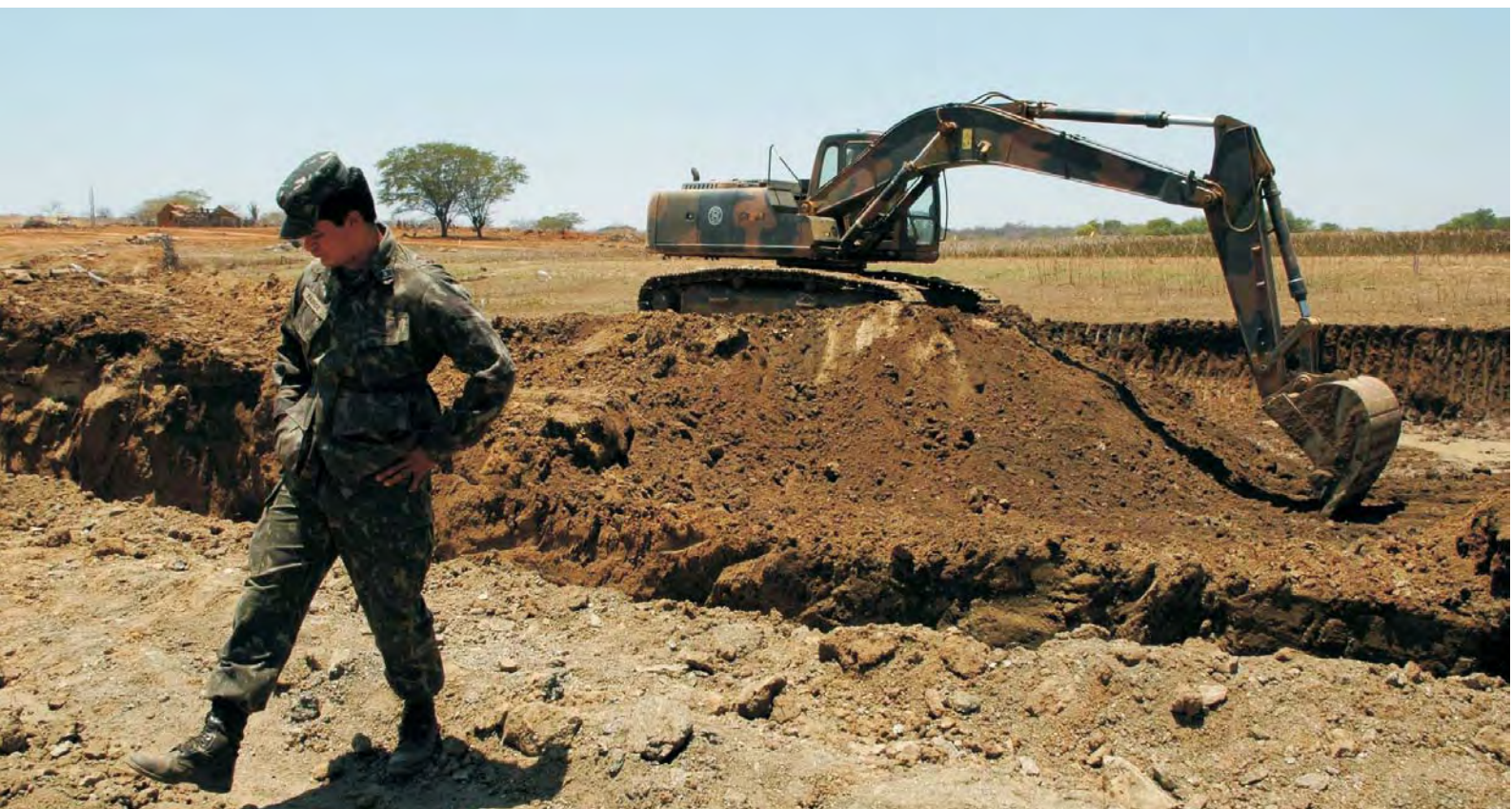
Figura 39: Canteiro de obras eixo Leste da transposição (ZINCLAR, 2007)
