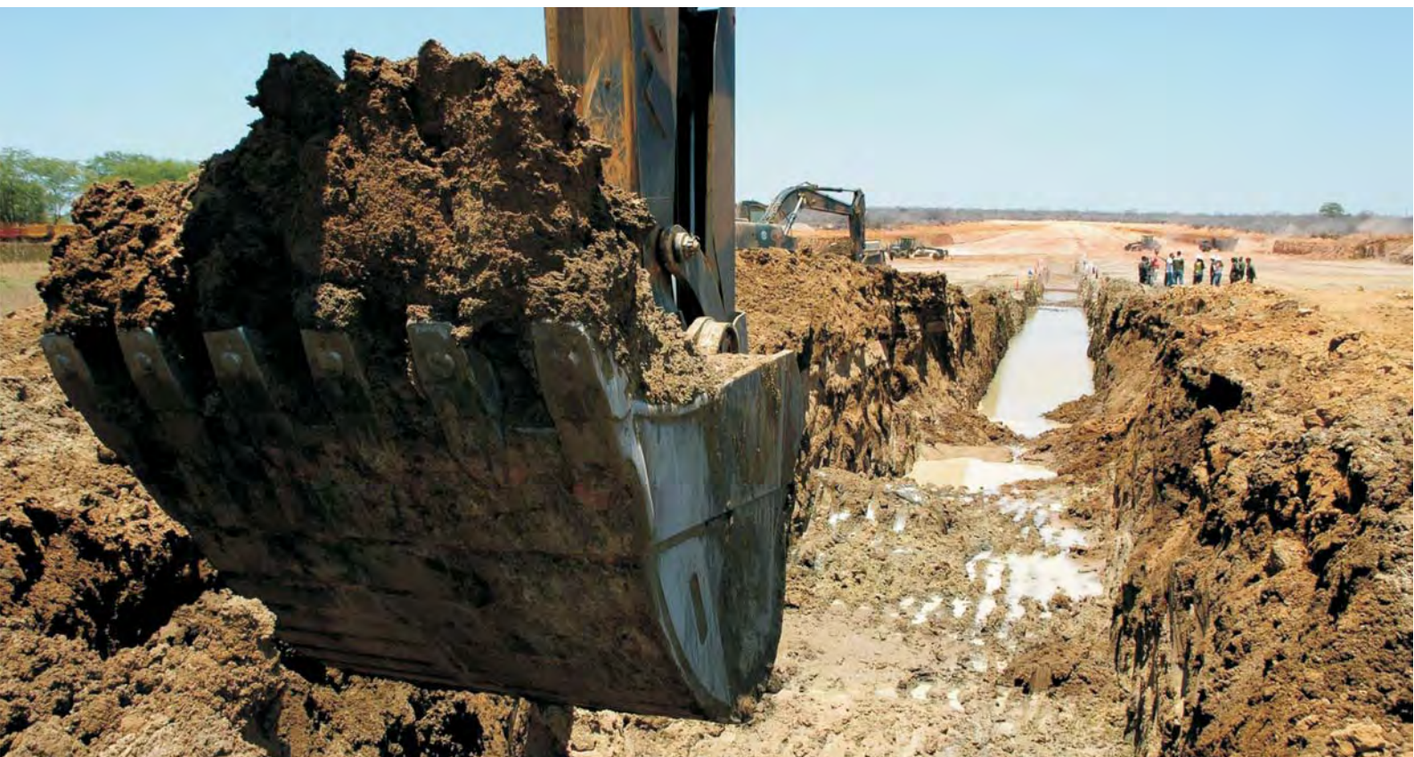
Figura 37: Canteiro de obras eixo Norte da transposição (ZINCLAR, 2007)
