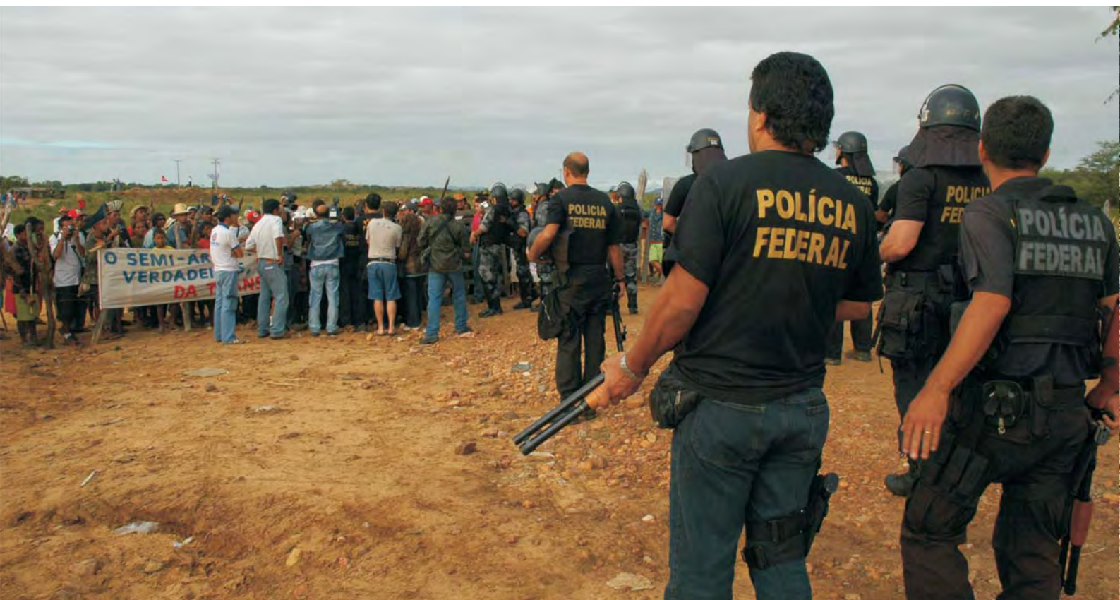
Figura 36: Canteiro de obras eixo Norte da transposição (ZINCLAR, 2007)
