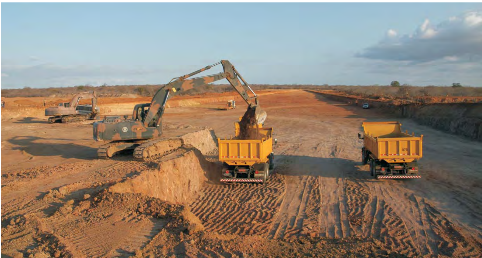
Figura 40: Canteiro de obras eixo Leste da transposição (ZINCLAR, 2007)
