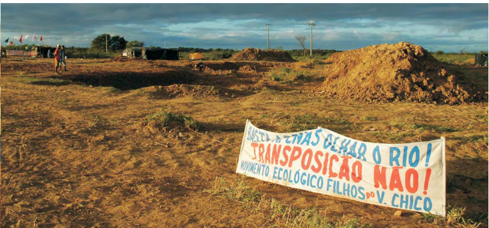
Figura 35: Canteiro de obras eixo Norte da transposição (ZINCLAR, 2007)
