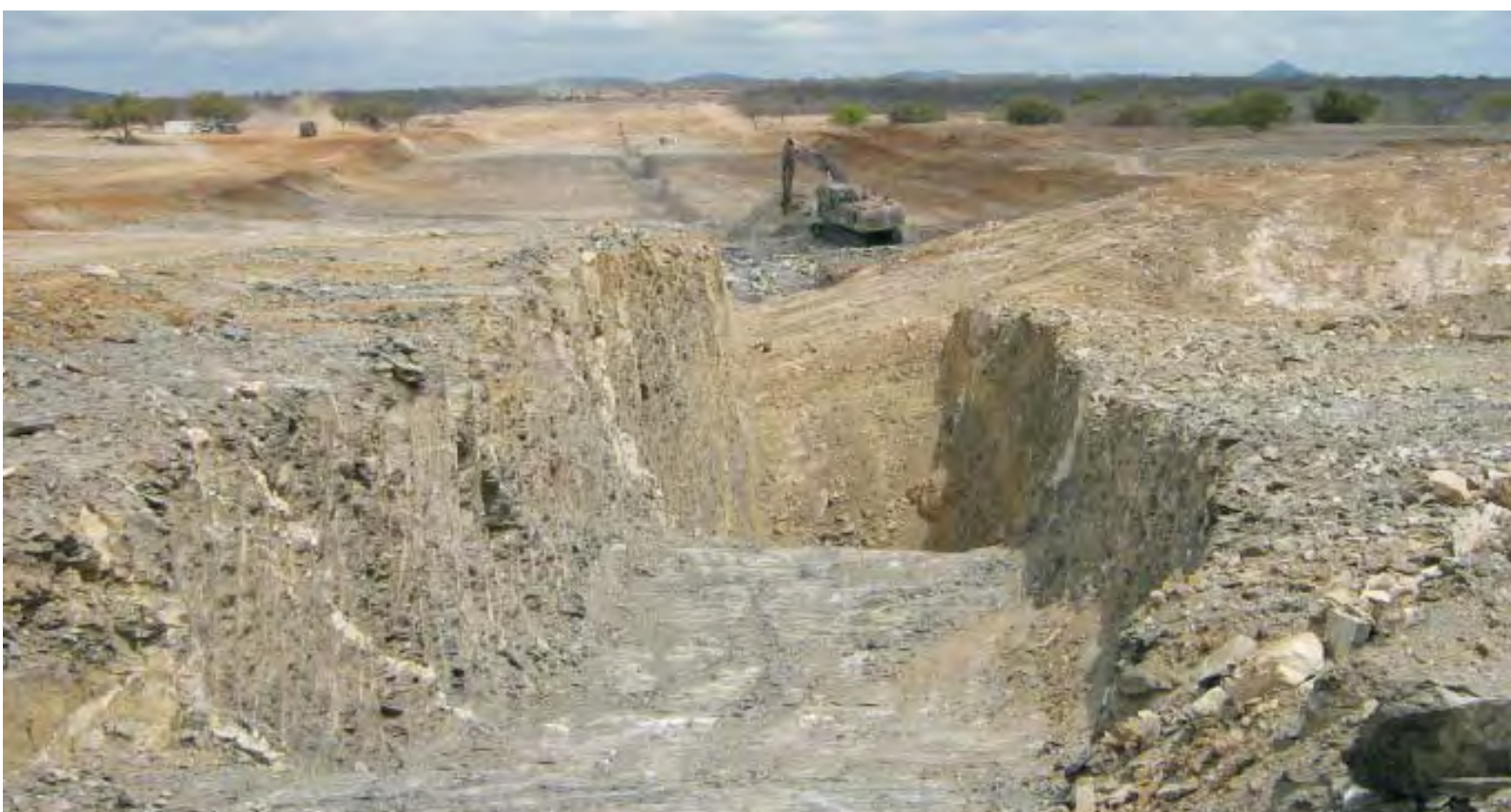
Figura 41: Canteiro de obras eixo Leste da transposição (ZINCLAR, 2007)
