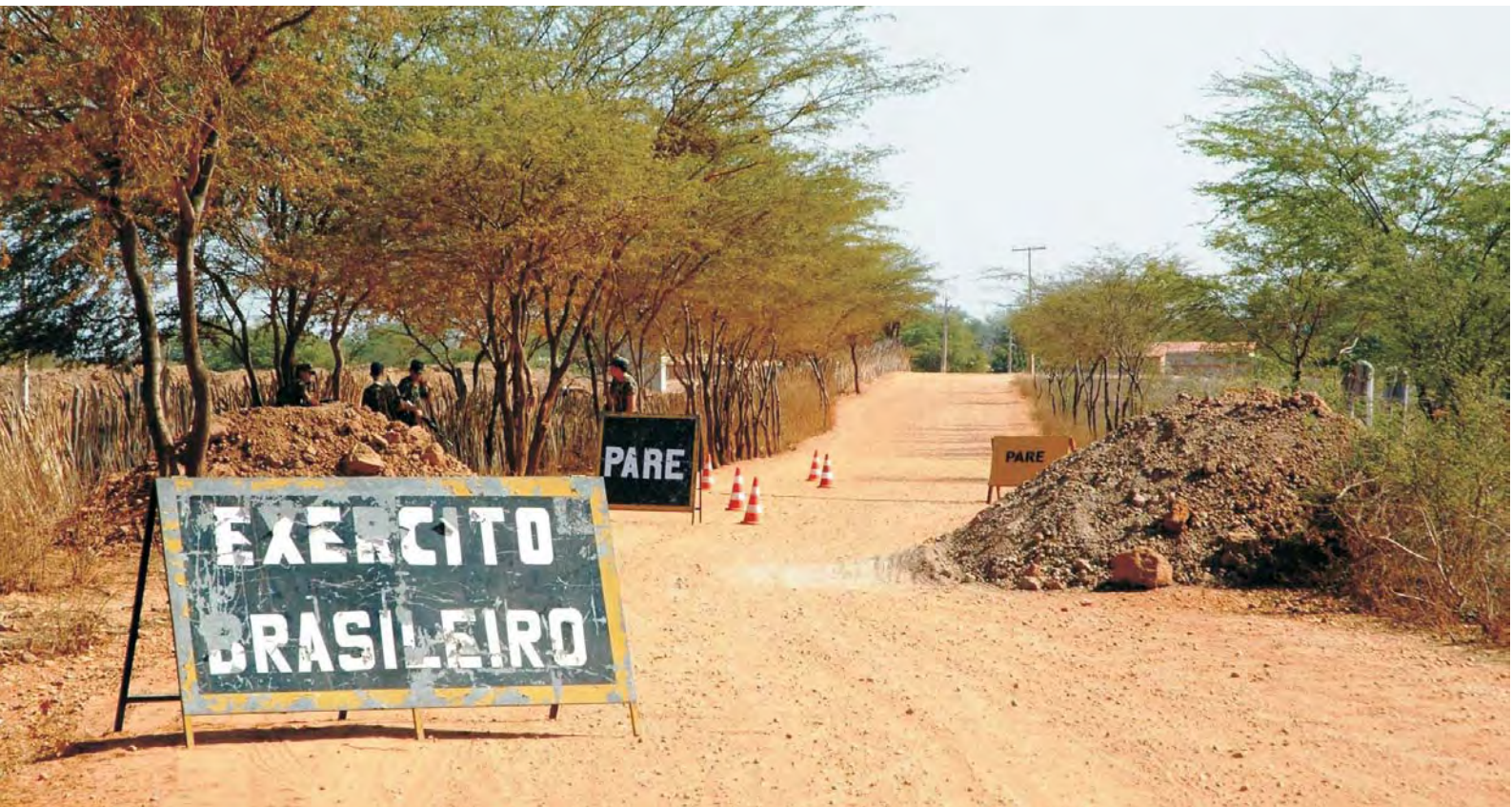
Figura 38: Canteiro de obras eixo Leste da transposição (ZINCLAR, 2007)
