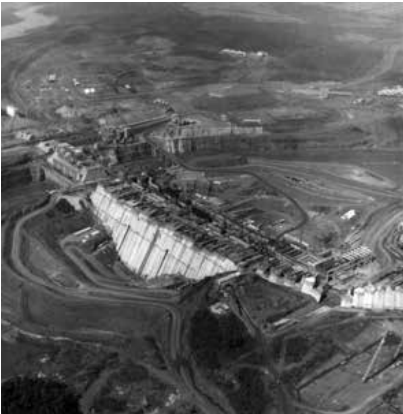
Canteiro de obras da Usina de Itaipu
