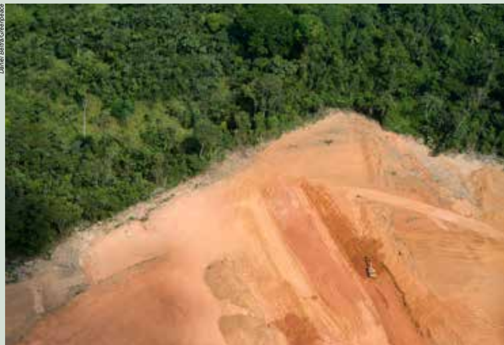
A enorme retroescavadeira fica quase imperceptível diante da dimensão da área desmatada, que antes era coberta pela Floresta Amazônica
